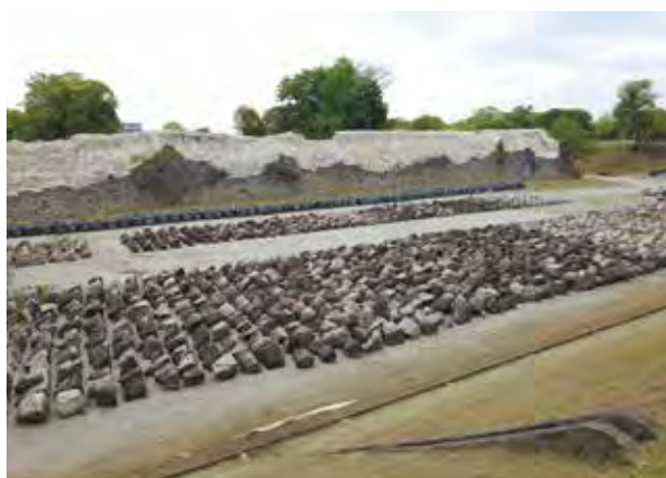
石垣の修復状況 (地震から10年、令和8年4月撮影)
