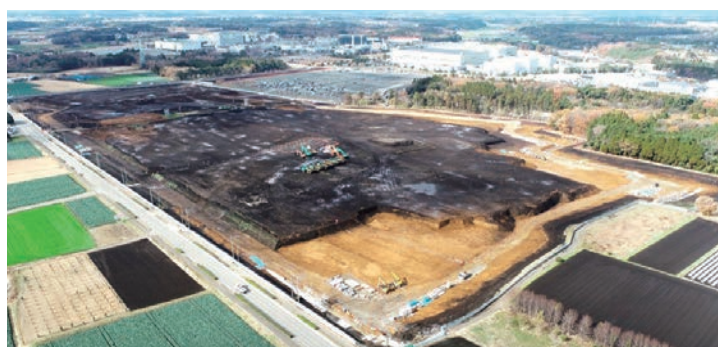
第二原水工業団地新工場建設用地
