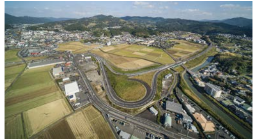
西九州自動車道佐々インターチェンジ
