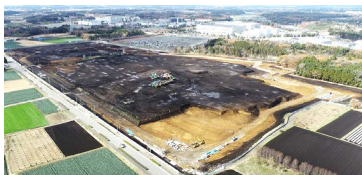
第二原水工業団地新工場建設用地
