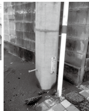
震度6強を観測した熊本市中央区でも、1階部分がピロティ構造の古いマンションでは、崩壊が見られました。また、南区近見地区の旧河川道跡の県道沿いで、液状化による家屋の不同沈下がみられました。写真の電柱は液状化により1mほど沈み、周りには噴砂がみられています。
