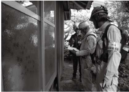
2次調査における外部調査
