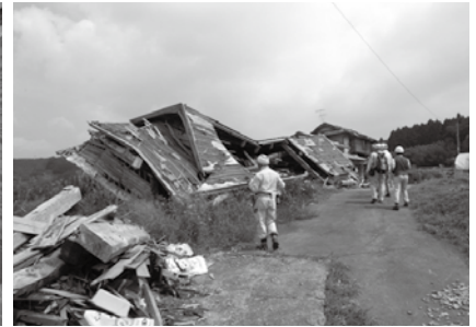
調査対象建物の悲惨な状況
