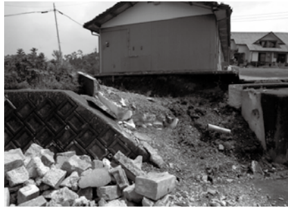
地盤の崩壊で基礎が浮いている建物
