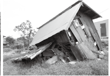
一見して明らかに倒壊している建物
