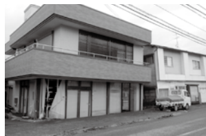
震度6強を観測した熊本市中央区でも、1階部分がピロティ構造の古いマンションでは、崩壊が見られました。また、南区近見地区の旧河川道跡の県道沿いで、液状化による家屋の不同沈下がみられました。写真の電柱は液状化により1mほど沈み、周りには噴砂がみられています。
