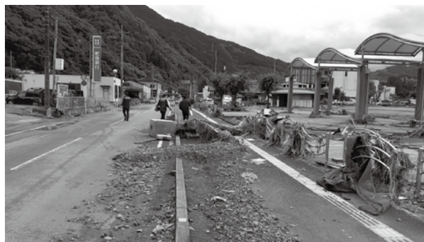
被災状況の視察(八代市役所坂本支所付近)
