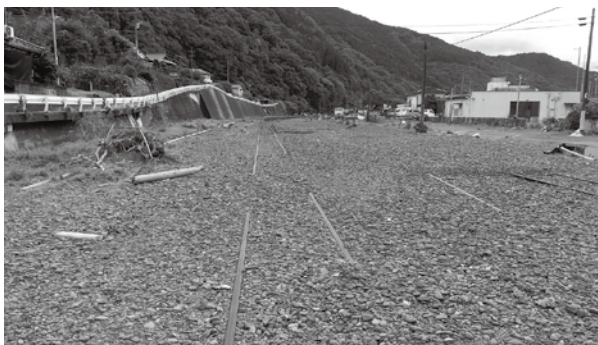
土砂で埋まる線路(肥薩線坂本駅付近)
